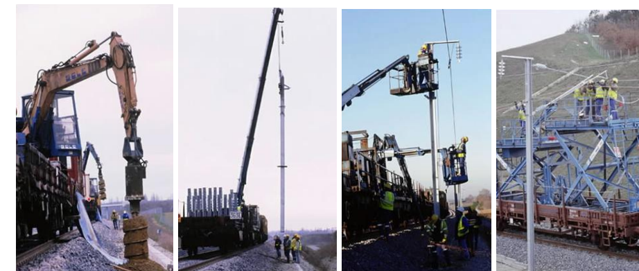
Figure 89 : Les différentes étapes de pose de la LAC
