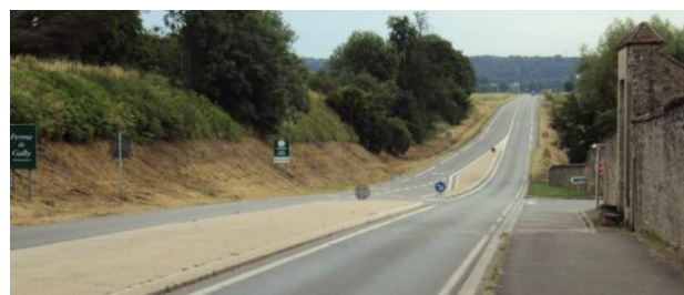
Figure 44 : localisation du Pont-Rail de la RD7
