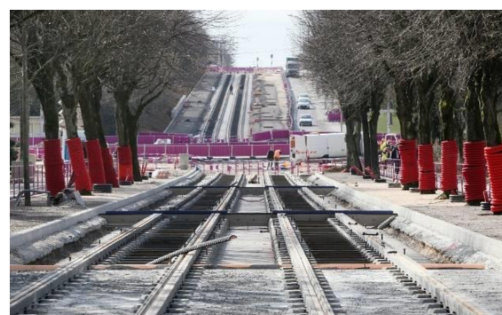
Figure 88 : Travaux de construction de la plateforme du Tramway – Dijon
