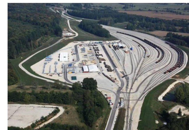
Figure 79 : Base travaux sur la ligne LGV Est
