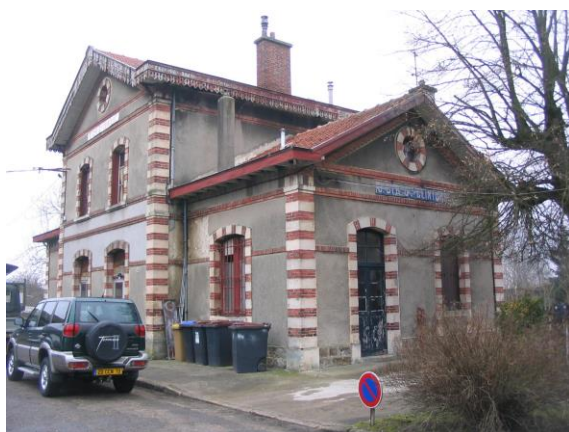
Figure 92 : Ancienne gare de Saint-Cyr GC
