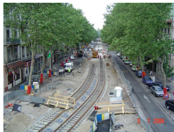
Figure 87 : Mise en place des rails
