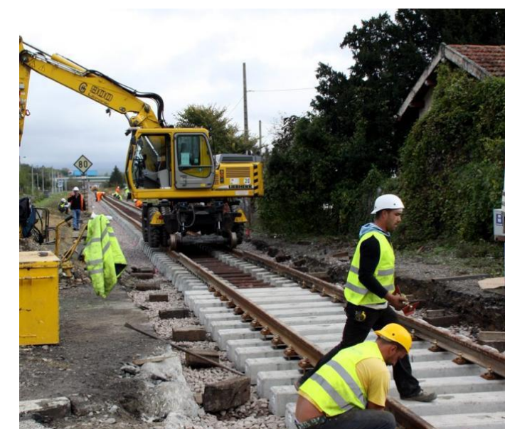
Figure 90 : Exemple de train travaux
