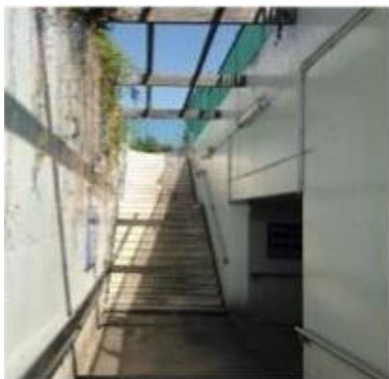
Figure 66 : Gare de Mareil-Marly (passage souterrain)
