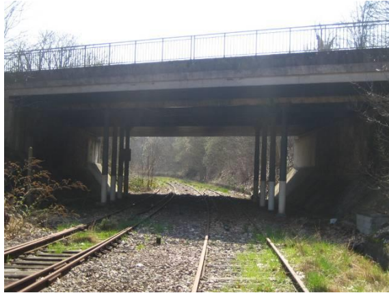
Figure 42 : Pont de la RD10 (ouvrage nord)
