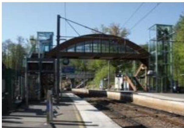
Figure 63 : Gare de Saint-Nom-la-Bretèche (quai, passerelle et ascenseur)
