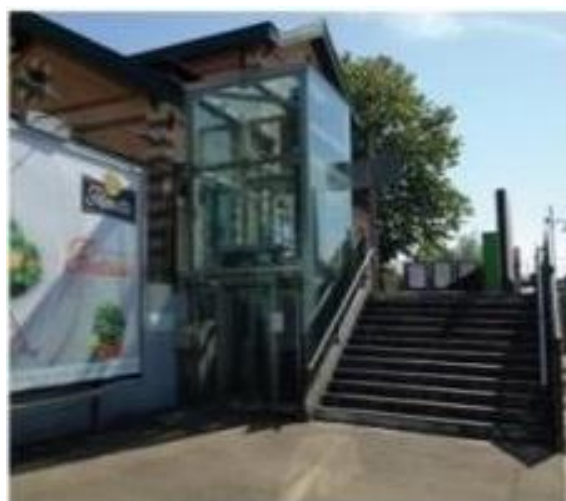
Figure 65 : Gare de Noisy-le-Roi (ascenseur)
