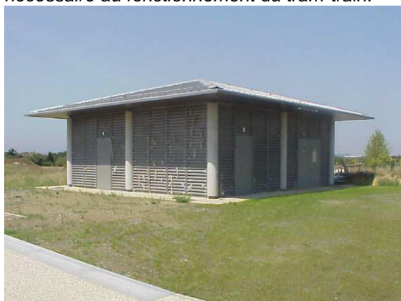
Figure 82 : Local à sous station électrique (Source : Egis rail)
